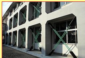
高田小学校 耐震補強工事
