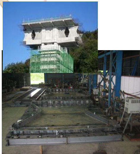
バタフライ構造型枠
