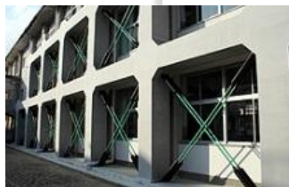
耐震補強平行構法
